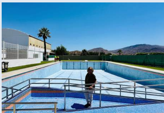
Nueva rampa de acceso para la piscina Municipal
