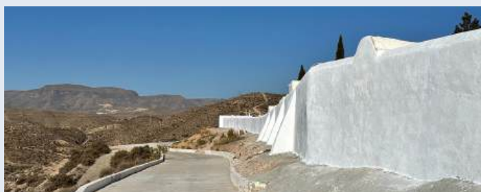
Restauración del muro del Cementerio
