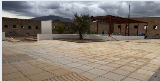
Colocación de solería en el Hotel Rural
